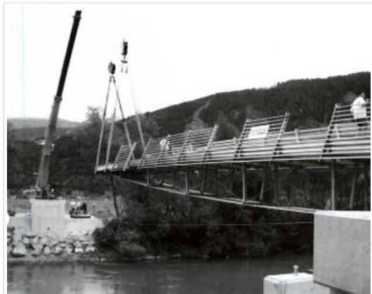
Die Eröffnung erfolgte am Nationalfeiertag des Jahres 2000. Der Radweg R7 von Liezen nach Selzthal wird kurz außerhalb des Stadtgebietes mittels einer 45 m langen und 40t schweren Brücke über die Enns geführt. Diese Brücke wurde von einem oberösterreichischen Spezialunternehmen aus Holz und Stahl gefertigt und komplett montiert angeliefert. Ein Drittel der Kosten trug die Stadtgemeinde, den Rest teilten sich Land und Bund.
