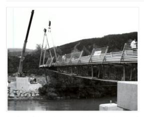
Die Eröffnung erfolgte am Nationalfeiertag des Jahres 2000. Der Radweg R7 von Liezen nach Selzthal wird kurz außerhalb des Stadtgebietes mittels einer 45 m langen und 40t schweren Brücke über die Enns geführt. Diese Brücke wurde von einem öberösterreichischen Spezialunternehmen aus Holz und Stahl gefertigt und komplett montiert angeliefert. Ein Drittel der Kosten trug die Stadtgemeinde, den Rest teilten sich Land und Bund.
