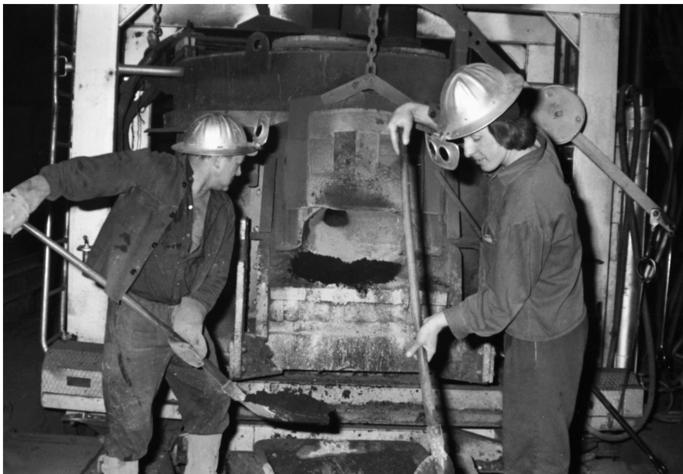
Bild 1: Schweißtreibende Handarbeit am 3-t-Elektroofen: Zuschlagstoffe bestimmen die Qualität
