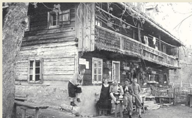
Trotz der vorgeschriebenen Verbesserung der Ausstattung ist das Gasthaus Schlagerbauern noch heute weitgehend das Bauerngasthaus geblieben, von denen es früher in Liezen viele gegeben hat.
