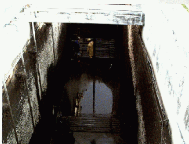
Im acht Meter tiefen Belebungsbecken werden die schadhaften Belüfterplatten ausgetauscht. Durch die oft unzulässige Benützung der Städtischen Kanalisation als „Müllschlucken“ wird die Lebensdauer dieser Geräte leider stark reduziert.
