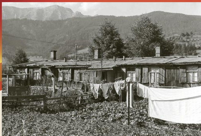
Ab 1940 wurden zirka 40 Baracken für rund 1.500 Zwangsarbeiter aus dem Osten gebaut. Nach dem Krieg wohnten Arbeiter- und Flüchtlingsfamilien in diesen Baracken. Erst 1968 konnte die letzte Baracke abgerissen werden.
