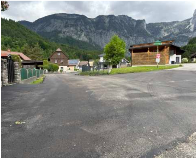
Im Ortsteil Weißenbach wurde die Baustelle der schon sanierungsbedürftigen Dorfstraße von der Einmündung Schalenweg bis auf Höhe Sengsschmied fertiggestellt.
