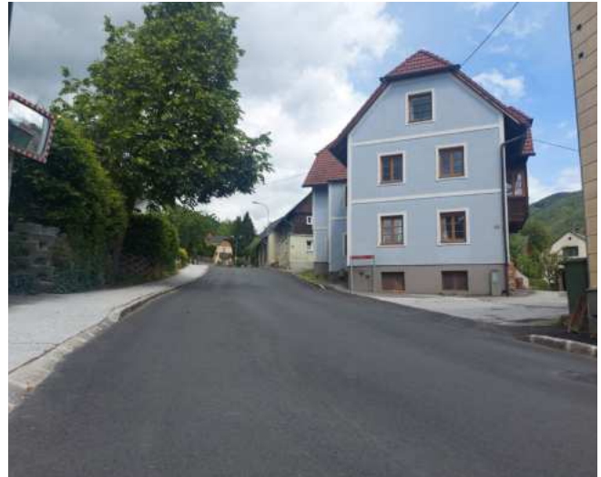
Ebenfalls abgeschlossen sind die Sanierungsarbeiten des Oberdorferweges von der Salzstraße bis zur Einmündung in die Alpenbadstraße.
