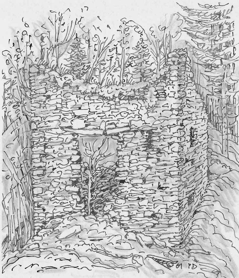
(Bild 5) Turmruine, derzeitiger Zustand, Federzeichnung des Verfassers
