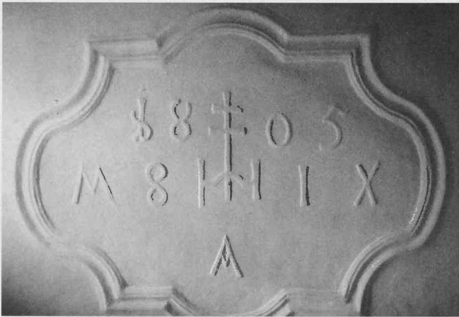
(Bild 5) Stuckarbeit im Obergeschoss Rainstrom 7
