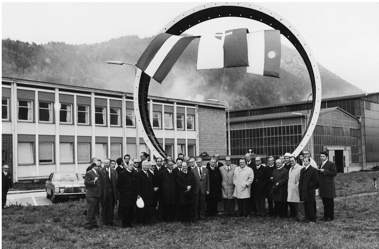
Die Linie 1 der Wiener U-Bahn fährt noch immer in Röhren (Tübingen), die in Liezen hergestellt wurden. Das Bild vom 15. Oktober 1971 zeigt den damaligen Wiener Stadtrat Kurt Heller bei einem Besuch in Liezen. Der Tübbing im Bild steht noch immer vor dem Verwaltungsgebäude des Werkes.
