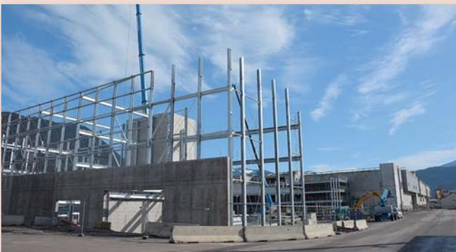
Nach Fertigstellung des Rohbaus für den Verkaufsbereich mit Jahresende 2015 wurde vor einigen Wochen im direkten Anschluss westlich mit der Errichtung des viergeschoßigen Parkhauses begonnen. Dieses wird als Stahl-Beton-Konstruktion ausgeführt. Zwischen den Stahlstützen werden die Parkflächen aus Betonfertigteilen verlegt.
