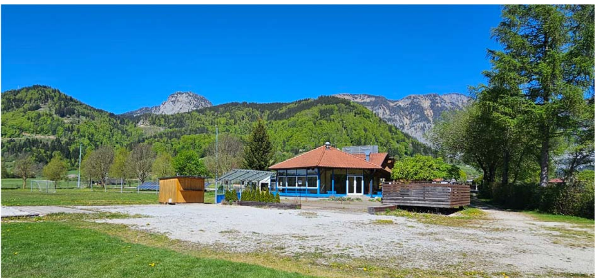
Abb. 6, Ansicht von Süden, 2026
