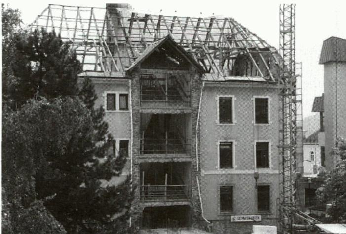
*Öffnung des Stiegenhauses an der Westseite und Entfernung der Dachkonstruktion mit bereits abgedecktem Dach.*
