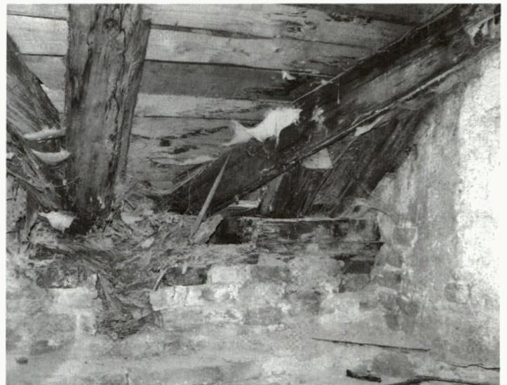
*Zeigt die angemorschten tragenden Konstruktionsteile des Dachstuhles im Bereich des Erkers.*
