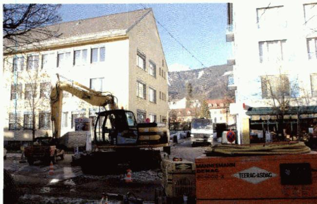
Bei starken Regenfällen kam es durch das von Norden anströmende Oberflächenwasser immer wieder zu Überschwemmungen in den Kellern der Häuser Hauptplatz 6, 8 und 10. Nach Errichtung eines Entlastungskanales im Bereich des Hauptplatzes werden diese Probleme der Vergangenheit angehören.
