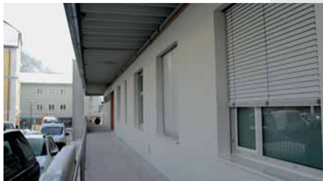
Auch der Nordzugang ist an einer Seite ebenerdig und somit behindertengerecht ausgestaltet.
