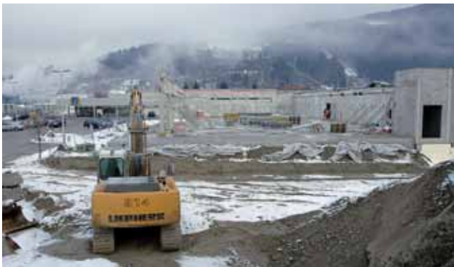
Baufortschritt trotz vorzeitigem Wintereinbruch: Der dann größte und modernste Hofer-Markt in der Steiermark – auch eine Tiefgarage wird errichtet – eröffnet voraussichtlich im April 2006.
