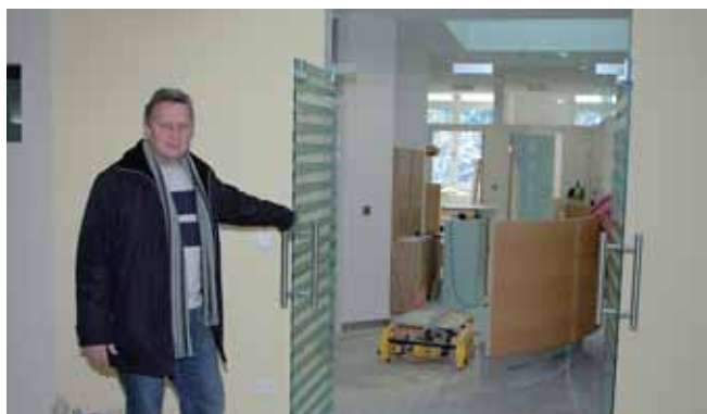
Der verantwortliche Bauleiter der Siedlungsgenossenschaft Ennstal: Ing. Gerald Steiner.
