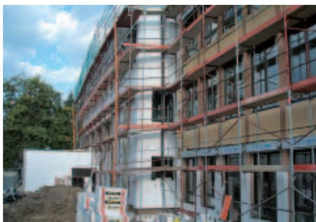
Ein Teil des Sanierungskonzeptes für die Hauptschule: Die Anbringung eines Vollwärmeschutzes an den Fassaden des gesamten Gebäudekomplexes.
