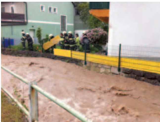
Die Feuerwehr Liezen-Stadt und Mitarbeiter des Städtischen Bauhofes errichteten bei einem Wohnhaus am Pyhrnbachufer einen Hochwasserschutz.
