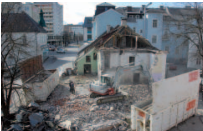
Im März 2013 wurde mit den Abbrucharbeiten begonnen.
