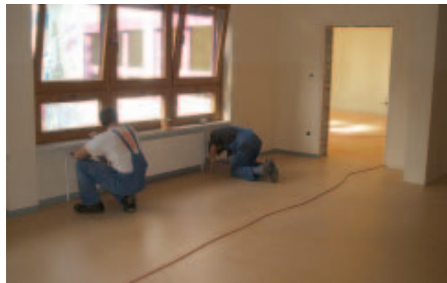
Auch sämtliche Böden wurden im ersten Obergeschoß des Kindergartens erneuert.
