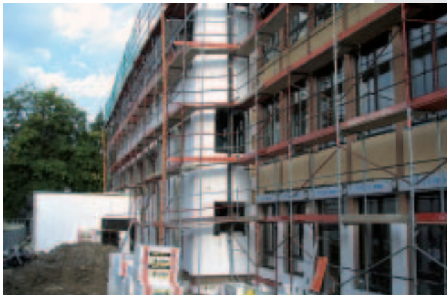
Die Fassade der Hauptschule erhält einen Vollwärmeschutz.
