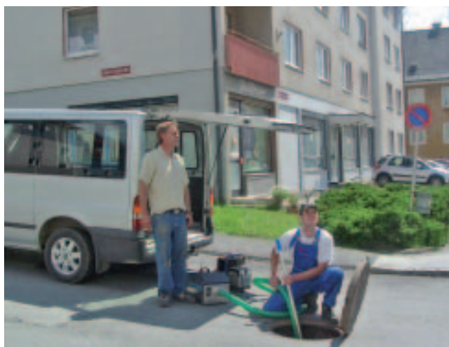
Mit eigenen Nebelmaschinen wird von der Kanalabteilung der Städtischen Bauhofes abschnittsweise überprüft, ob das jeweilige Objekt richtig an den Kanal angeschlossen ist.
