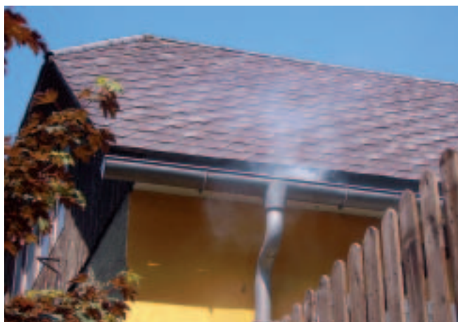
Der Austritt des erzeugten Nebels gibt Auskunft über den tatsächlichen Anschluss der Regenwässer.
