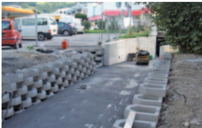
Aus Richtung Süden vom Bahnhof ist die Unterführung nun ohne Stufen erreichbar.
