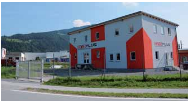
Das neue Betriebsgebäude der Firma EINS-PLUS im Wirtschaftspark Liezen.
