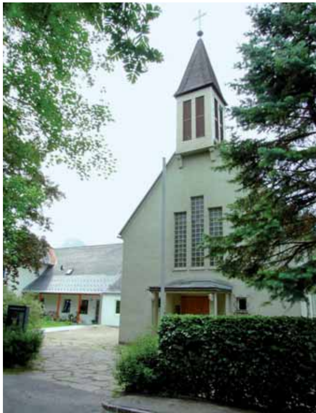
Die Auferstehungskirche im Liezener Ortsteil „Friedau“.
