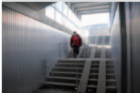
Die derzeitige Rampe in der Unterführung ...
