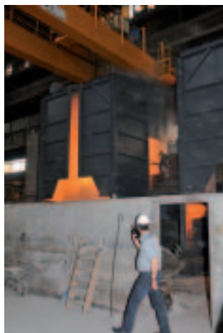
Die Schmelzöfen in der Gießerei mit ihren neuen Einhausungen.
