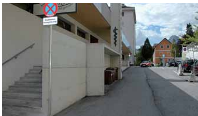
An der Nordseite des Ärzteentrums wurde über die gesamte Länge des Gebäudes ein Halte- und Parkverbot erlassen. Von diesem Verbot ausgenommen sind Rettungsfahrzeuge.
