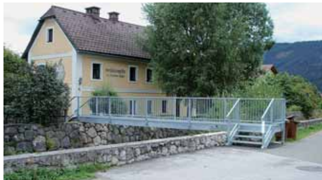
Die auffällige Fußgängerbrücke über den Pyhrnbach im Bereich der Alten Gasse wurde durch eine neue Stahlbrücke ersetzt. Die beiden anderen Brücken werden voraussichtlich im Jahr 2007 erneuert.
