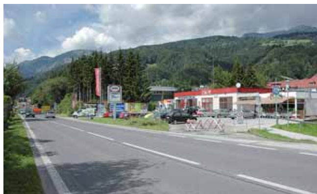
Mit den Bauarbeiten für die Neugestaltung der Ein- und Ausfahrt beim ARBÖ-Prüfzentrum an der B 320 Ennstalstraße wird in den nächsten Wochen begonnen. Nach Wegfall der Osteinfahrt erfolgt die neue großzügige Einbindung im Westen der Liegenschaft des ARBÖ. Gleichzeitig wird die bislang unübersichtliche Verbindung in die Siedlungsstraße verbreitert.
