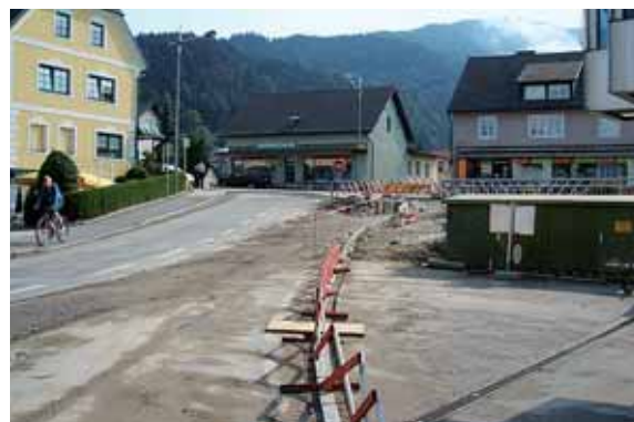
Auch der Umbau der Kreuzung Fronleichnamsweg – Hauptstraße wurde von der Firma Granit abgewickelt.
