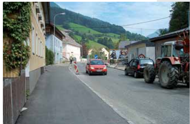
Kurz vor dem Abschluss stehen die Arbeiten zur Generalsanierung der B 138 Pyhrnpassstraße an der nördlichen Ortseinfahrt. Durch die Verbreiterung des Gehsteiges wird einerseits eine erhöhte Verkehrssicherheit für die Fußgänger und Radfahrer erzielt, andererseits sollte durch diese Maßnahme die Geschwindigkeit der Verkehrsteilnehmer auf der Straße vermindert werden.
