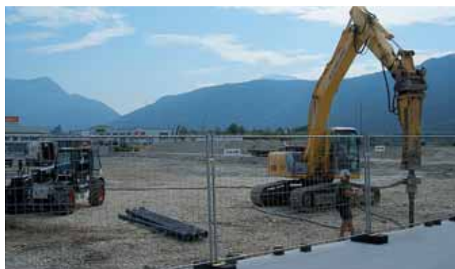
Vor kurzem wurde mit den Bauarbeiten zur Errichtung des Fachmarktcenters an der Gesäusestraße zwischen PENNY/BIPA und Reifen Ruhdorfer begonnen. Die Fertigstellung ist für das Frühjahr 2007 vorgesehen.
