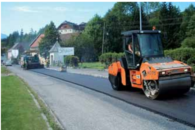
Kurz vor dem Abschluss stehen die Arbeiten zur Generalsanierung der B 138 Pyhrnpassstraße an der nördlichen Ortseinfahrt. Durch die Verbreiterung des Gehsteiges wird einerseits eine erhöhte Verkehrssicherheit für die Fußgänger und Radfahrer erzielt, andererseits sollte durch diese Maßnahme die Geschwindigkeit der Verkehrsteilnehmer auf der Straße vermindert werden.
