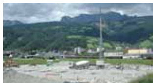
Die Baustelle an der Schönaustraße.
