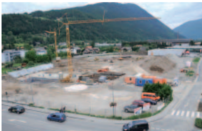
Knapp 1,5 Hektar umfasst das Gelände der EUROSPAR-Baustelle im südlichen Stadtzentrum.
