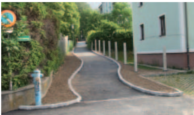
Die Bauarbeiten zur Umgestaltung des Buchenweges konnten vor kurzem abgeschlossen werden.
