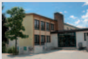
Im Sommer 2007 fällt der Startschuss für die Hauptschulsanierung.
