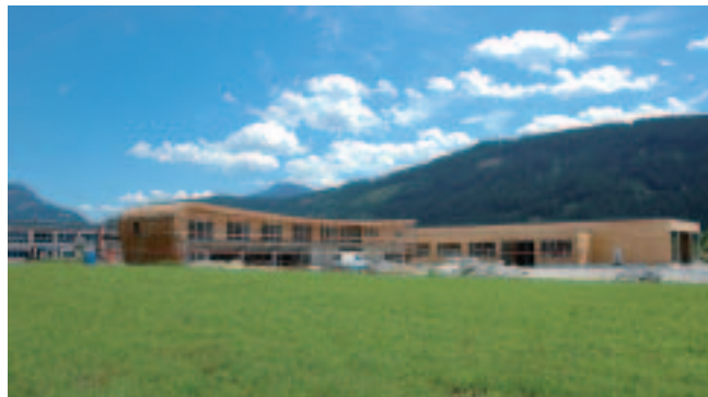
Bereits im August werden die neuen Büroräume und die Lager- und Werkstatthallen der Wildbach- und Lawinerverbauung westlich des Wirtschaftsparks in Betrieb genommen. Die offizielle Übergabe wird Anfang Oktober 2007 erfolgen.
