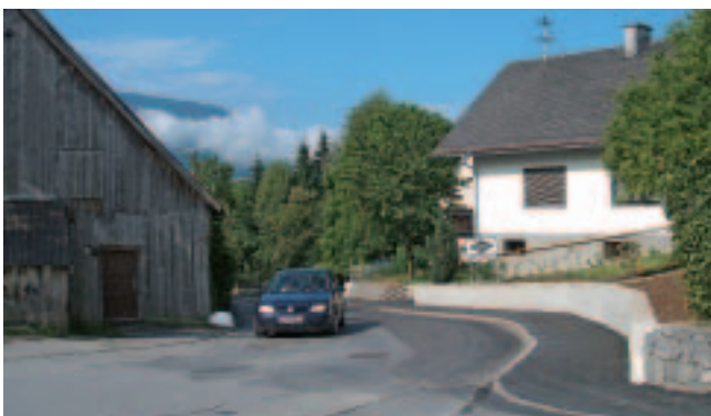
Nach der Verbreiterung im Herbst 2006 wurden die Arbeiten zum Ausbau des Oberdorfer Weges beim sogenannten „Hödl-Eck“ mit Errichtung des Gehsteiges und der westseitigen Stützmauer abgeschlossen. Eine jahrzehntelange Engstelle konnte somit „entschärft“ werden.
