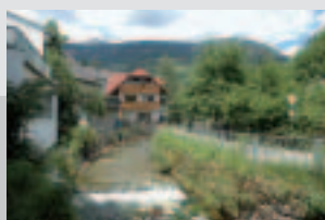
Die Voraussetzungen für den Pyhrnbachausbau wurden geschaffen.
