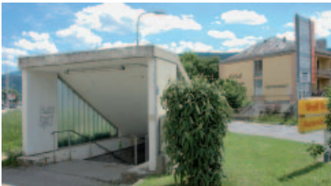
Die unansehnliche und nicht mehr zeitgemäße Unterführung der B 320 Ennstalstraße im Bereich des Hotels Karow und der Firma Eurospar wird generalsaniert und umgebaut. Die Bauarbeiten sollen noch bis zum Herbst 2007 abgeschlossen werden.
