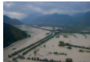
Die Folgen: Überflutungen 2002
