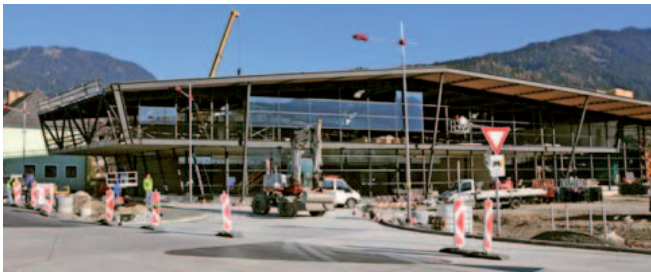
Tag für Tag lässt sich mehr erahnen, welche interessante, architektonische Form sich hier entpuppt: Die gänzlich verglaste Fassade sowie die Tageslichtöffnungen im Dach werden für viel Licht und Transparenz in diesem energieoptimierten Gebäude sorgen.
