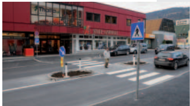
Der Fußgängerübergang nördlich des Kreisverkehrs wurde von der Stadtbuchhandlung Liezen zur Stadtapotheke verlegt.
