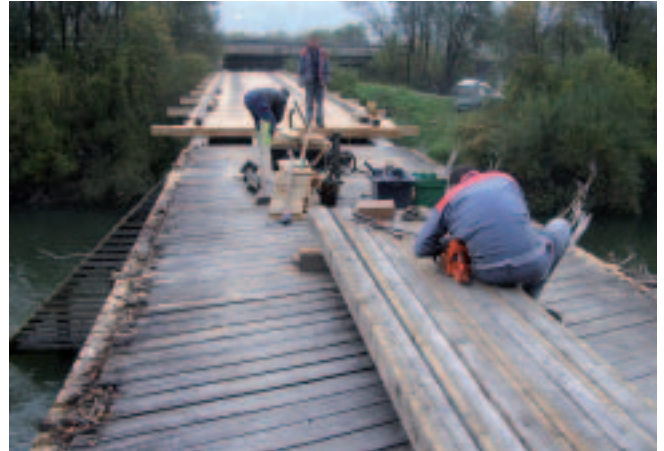
Die Radwegbrücke im Ortsteil Reithtal wurde in beispielhaftem „Teamwork“ dreier Gemeinden generalsaniert.
