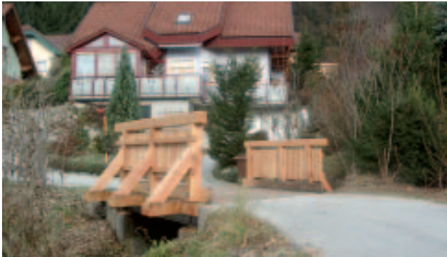
... und auch jene im südlichen Bereich wurden heuer durch den Städtischen Bauhof erneuert.
