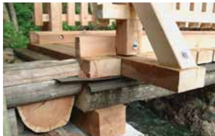
An richtiger Stelle montierte Schutzbleche erhöhen die Lebensdauer des Naturbaustoffes Holz.
