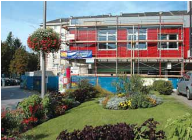
Kurz vor ihrer Fertigstellung befindet sich die mit verspiegelten Emailglas-Elementen versehene Fassade im angenehmen Rot-Ton sowie die in Grau gehaltene Alublech-Verkleidung. Für eine behindertengerechte Erreichbarkeit des Ärztezentrum auch vom Rathausplatz aus wird an der Südfront ein Zubau mit einer geräumigen Aufzugsanlage errichtet.
