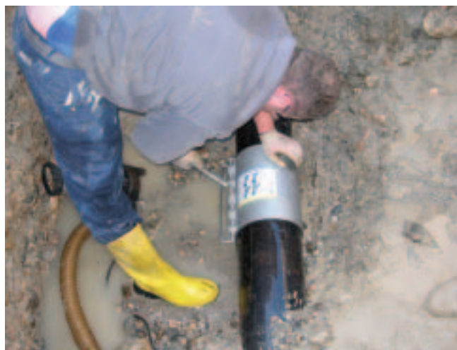
Aufgrund des Schadensbildes erfolgt die Behebung der oben abgebildeten Schadstelle durch das Personal des Städtischen Wasserwerkes mit einer Reparaturschelle.
