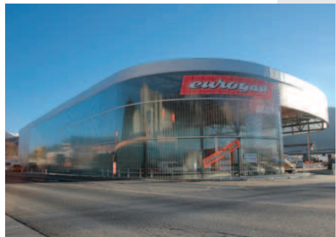
Der Eurogast-Markt an der Bundesstraße wurde Mitte Februar in die Sammlung des Architekturzentrums Wien aufgenommen.
