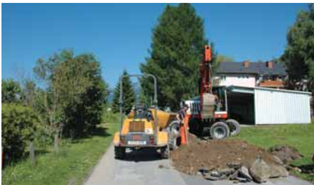
... kann es durch die Erneuerung der Wasserleitung und des Kanals zu Behinderungen kommen.
