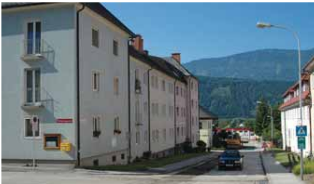
Im Bereich Siedlungsstraße, Dr.-Karl-Renner-Ring, Admonter Straße und Flurweg ...
