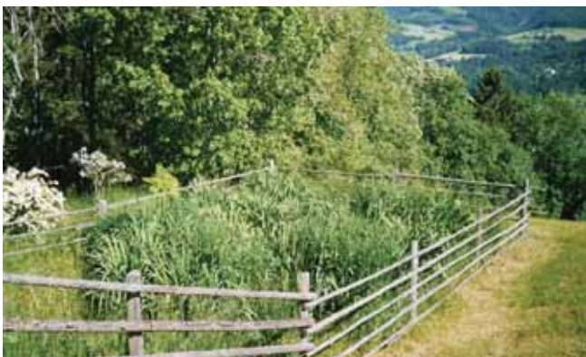
Die Pflanzenkläranlage fügt sich unscheinbar in die Natur ein.
