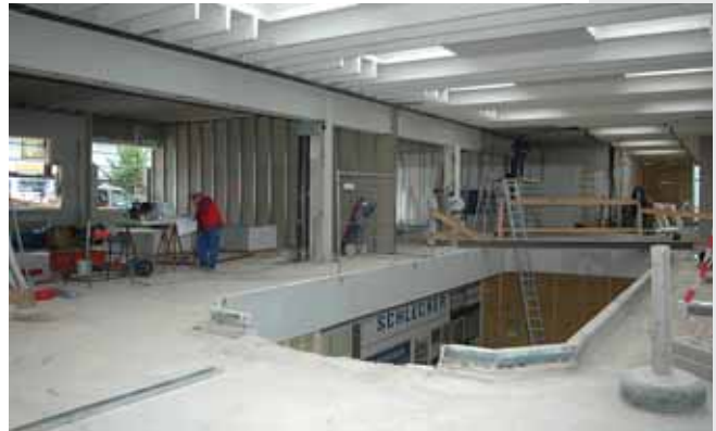
Die Innenstiege wurde entfernt, die dadurch gewonnenen Flächen kommen zum Gesundheitszentrum.
