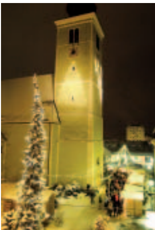
Die Installation der Kirchturmbeleuchtung im Kirchenviertel ist abgeschlossen.
