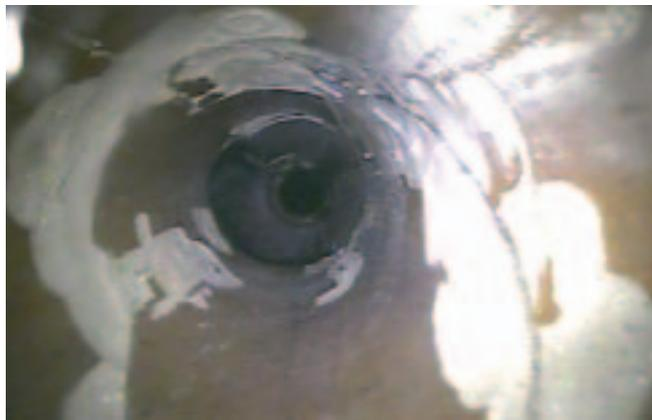
Der Fräsroboter hat die vorstehenden Kanten abgeschliffen.
