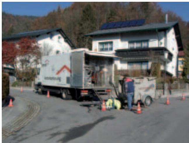
Kanalsanierung in der Tausingssiedlung: Einbau eines „Schlauchliners“.
