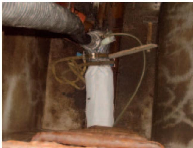
Der mit Polyesterharz getränkte „Schlauchliner“ wird in den zu sanierenden Kanal eingezogen, mit Druckluft aufgeblasen und anschließend mit UV-Licht ausgehärtet.
