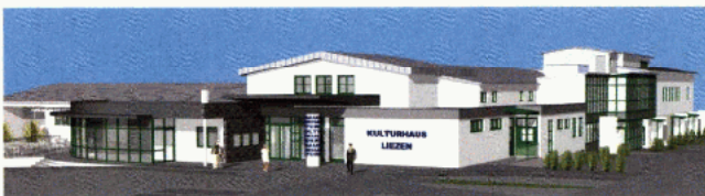
Die Gesamtansicht nach Abschluss der Adaptierungsarbeiten.
