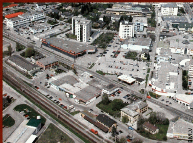
... als auch bei der Landgenossenschaft Ennstal und beim Areal „Ziegler“ an der Bahnhofstraße entstehen neue Projekte.
