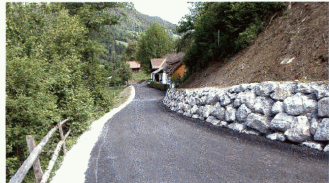
Die Arbeiten für den zweiten Bauabschnitt zum Ausbau der Straße „Am Salberg“ konnten sogar vorzeitig abgeschlossen werden. Im Zuge dieses Projektes erfolgte eine teilweise Neutrassierung. Gleichzeitig konnten ungünstige Steigungsverhältnisse entschärft und einige Böschungen abgesichert werden. Die Straßenbeleuchtung wird ebenfalls ergänzt bzw. erneuert.
