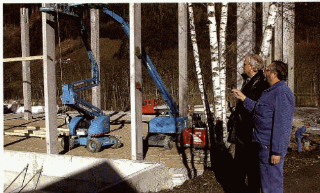
Abfallwirtschaftsverbands-Obmann Bürgermeister Rudi Hakel (im Bild mit AWW-Mitarbeiter Klemens Schwaiger) bei der Besichtigung der im Bau befindlichen Sortierhalle.
