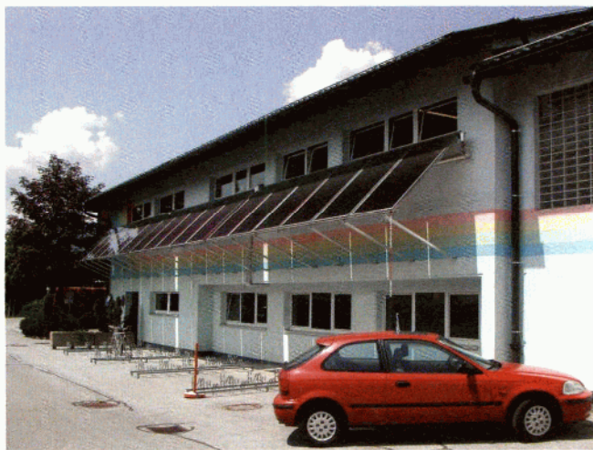
Warmwasser fürs Duschen wird jetzt aus Solarenergie gewonnen.
