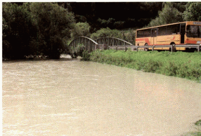
Die Verkehrsverbindung nach Selzthal über die Röthelbrücke kann trotz des bedenklichen Wasseranstiegs aufrecht erhalten werden.
