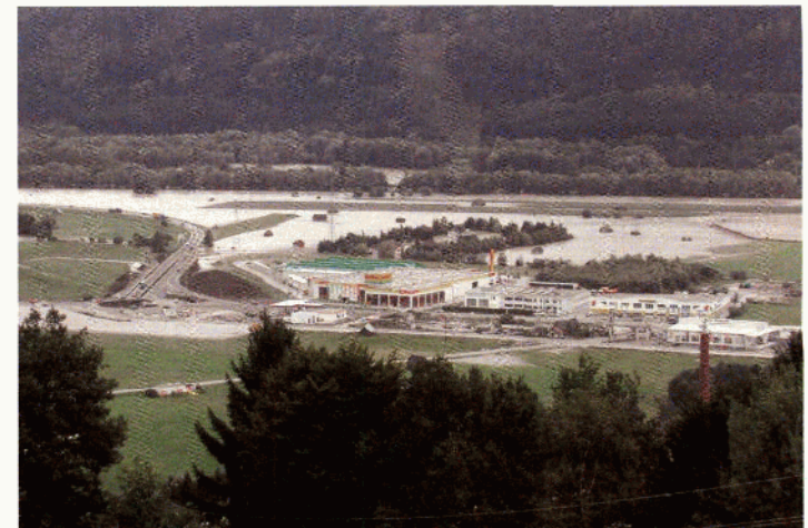
An der Osteinfahrt zur Stadt schützen Dämme vor einer Überflutung der Straßen. Die Kläranlage (Bildmitte) ist vom Hochwasser bereits erfasst.
