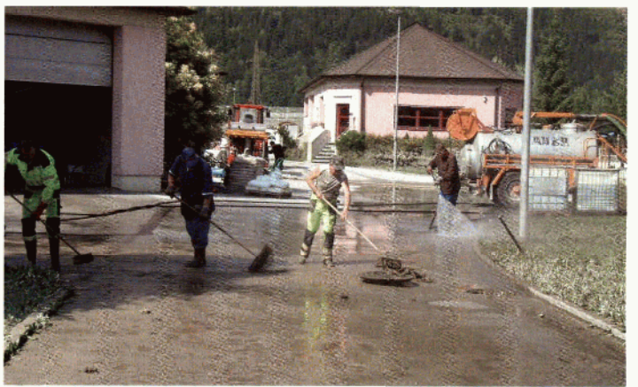
Nach den Aufräum- und Reparaturarbeiten in der Kläranlage hat diese schon wieder den Betrieb aufgenommen.
