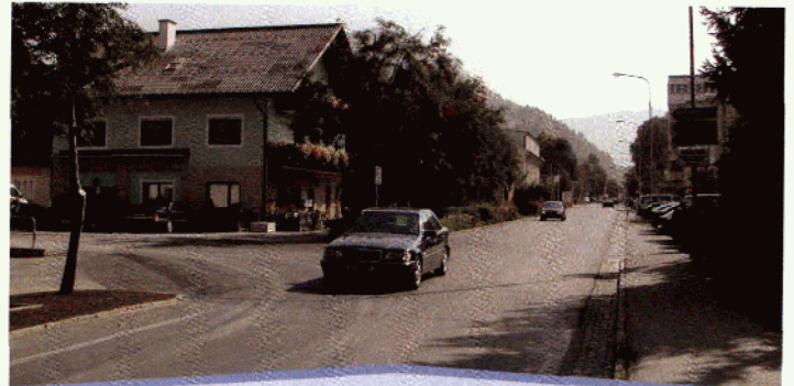
Die viel benutzte Ausseer Straße ist durch einen neuen Belag nicht nur attraktiver sondern zudem verkehrssicherer geworden.
