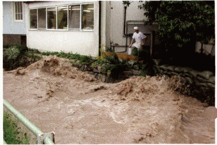
Bei der Bäckerei Steindl kommt es zum ersten Austreten des Pyhrnbachs. Durch das rechtzeitige Absichern mit Sandsäcken wird das Schlimmste verhindert.
