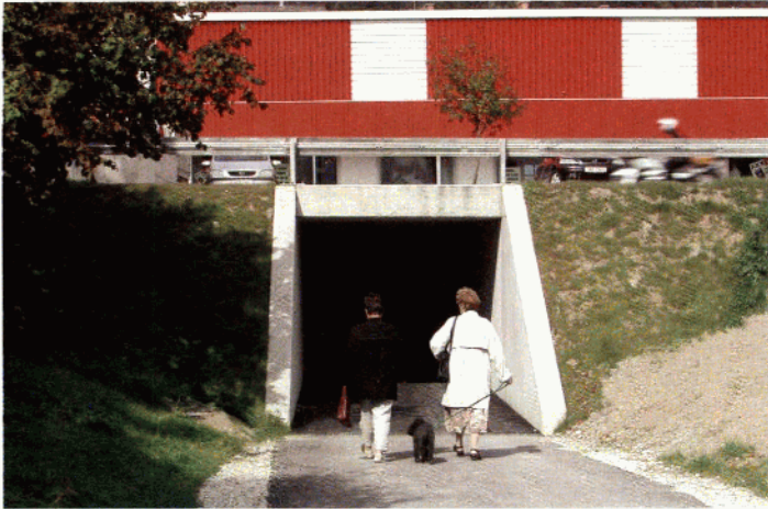
Sehnsüchtig erwartet: Die gefahrlos benutzbare Unterführung der Bundesstraße für Fußgänger und Radfahrer.
