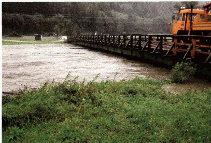
Der Wasserspiegel der Enns steigt ständig. Die Überführer-Brücke als Verbindung nach Döllach und Lassing muss gesperrt werden.
