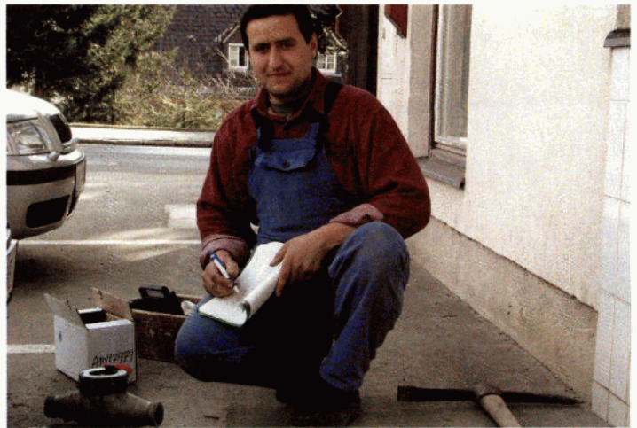
Das Bild zeigt Michael Essenko beim Zählerwechsel. Die Zähler müssen in einem Intervall von 5 Jahren geeicht werden. Jährlich sind ca. 230 Zähler aus- und einzubauen und z. Eichtung zu verschicken.
