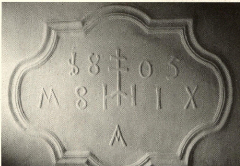
(Bild 5) Stuckarbeit im Obergeschoss Rainstrom 7
