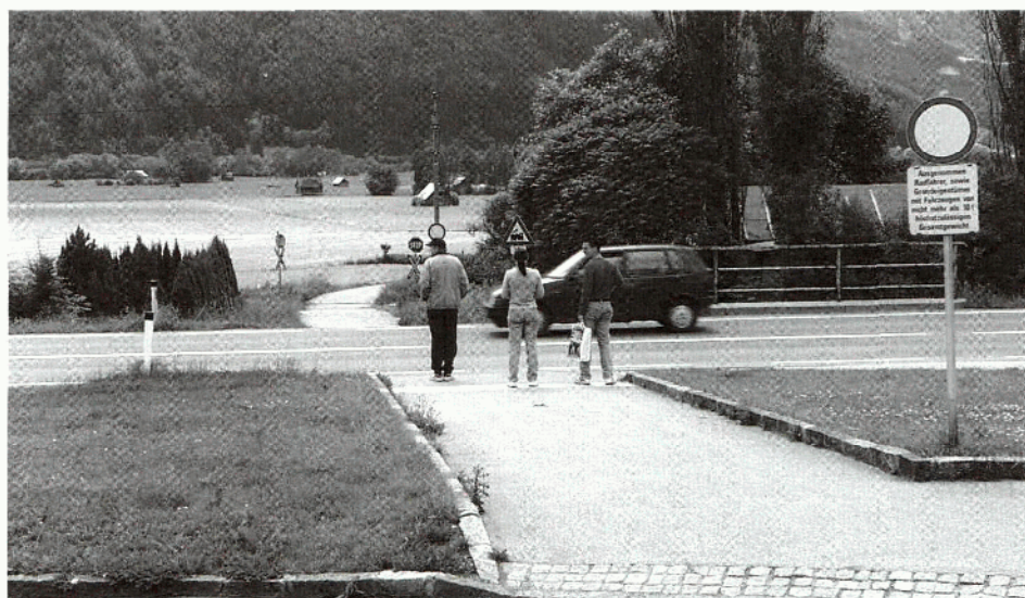
Ein neuralgischer Punkt an der Ennstal-Bundesstraße erfordert bauliche Maßnahmen
