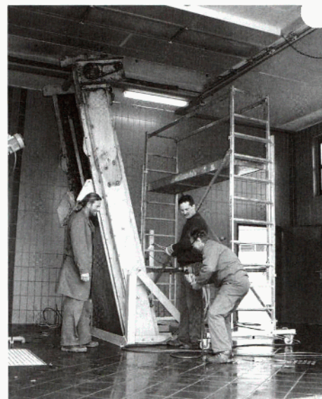
Die Kläranlage ist stets auf dem neuesten technischen Stand.
