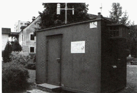
Die Mess-Station im Erzherzog-Johann-Park
