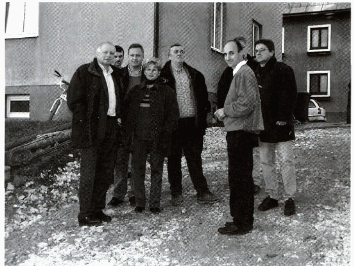
Die Mitglieder des Raumordnungs- und Infrastrukturausschusses besichtigten mit Vertretern der Feuerwehr die Baustelle
