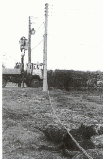
Bei der Arbeit an einem Ortsnetz in Monforton.
