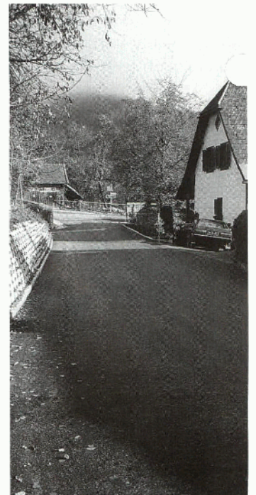
Besondere Anstrengungen erforderten die Bauarbeiten an der Höhenstraße.
