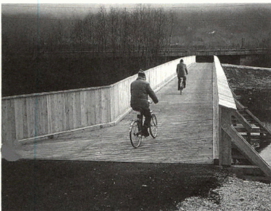
Enns-Radwegbrücke im Ortsteil Reiththal (S 4,2 Mio.)
