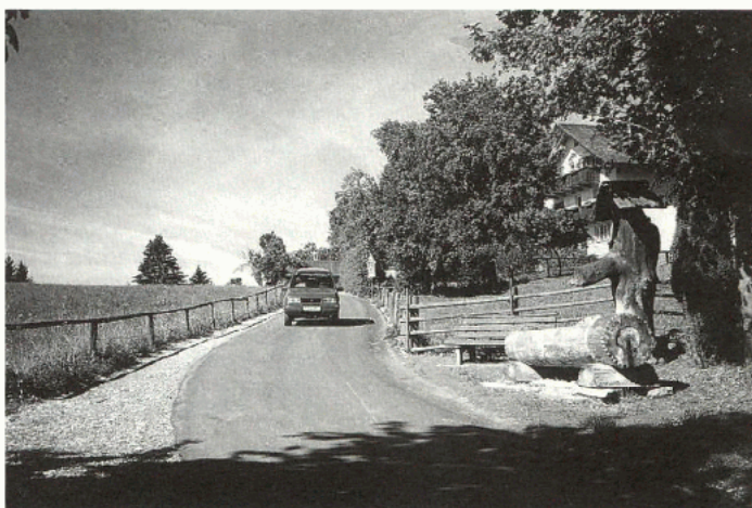
Generalsanierung der Höhenstraße beginnend bei der Eisbahn ESV Berg (S 5,5 Mio.)
