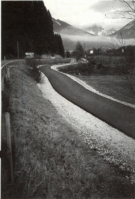
Asphaltierung des Radweges im Ortsteil Reiththal (S 950.000,-)
