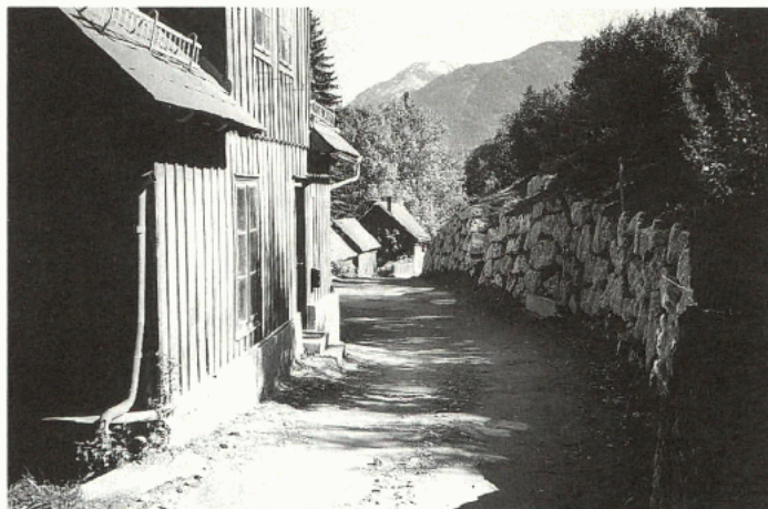
Ausbau und Sanierung des Salbergweges (bisher S 5,4 Mio.)
