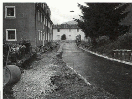
Neugestaltung Sanierung der Rosseggergasse
