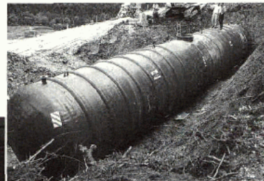
Einbau des Fertigteilhochbehälters für die Wasserversorgung des Ortsteiles Pyhrn
