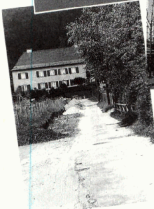
Verbreiterung des Schlagerbauerweges
