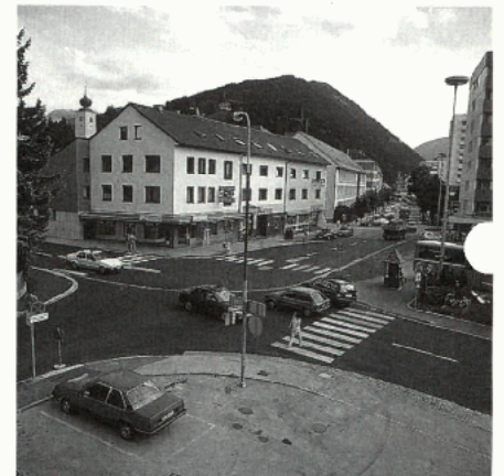
Generalsanierung der Döllacher Straße mit gleichzeitigem Umbau der "Wut- scher-Kreuzung"
