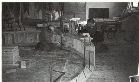
Restaurierung des Mühlrades der Gassner Mühle
