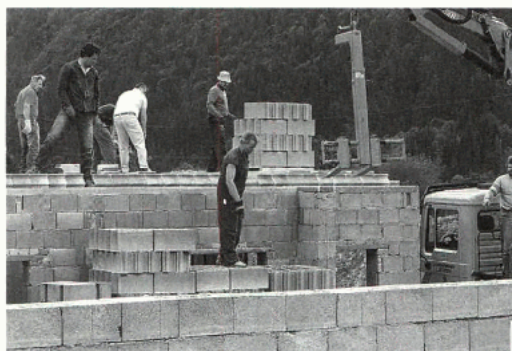
Baubeginn beim Rüsthaus für die Freiwillige Feuerwehr Pyhrn
