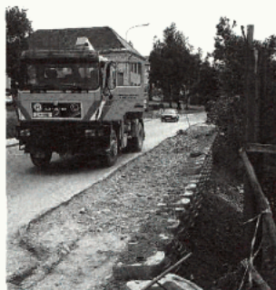
Verlängerung des Gehsteiges in der Ausseer Straße beim Vermessungsamt
