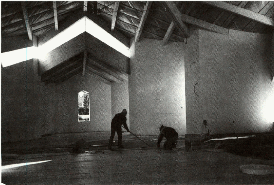
Die Innenansicht der Verabschiedungshalle zeigt die Verlegung der Fußbodenheizung
