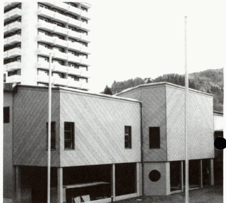
Der Bühnenraum wurde durch einen Zubau Richtung Süden verlegt.
