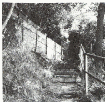
Steinschlagsicherung am Fußweg Rainstrom-Salbergweg
