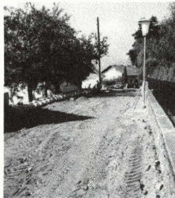
Nach Verlegung der Erdgas- und Wasserleitung sowie Verlegung des Oberflächenkanals wird die Kornbauerstraße im östlichen Bereich generalsaniert.
