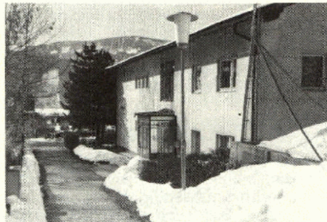
Übungskindergarten in der Nikolaus-Dumba-Straße (Sprengel 5 und 6)
