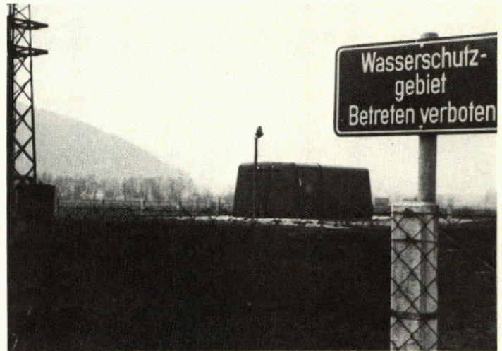
Ohne diesen Tiefbrunnen in den Ennswiesen wäre die Wasserversorgung im trockenen Herbst 1984 zusammengebrochen.
