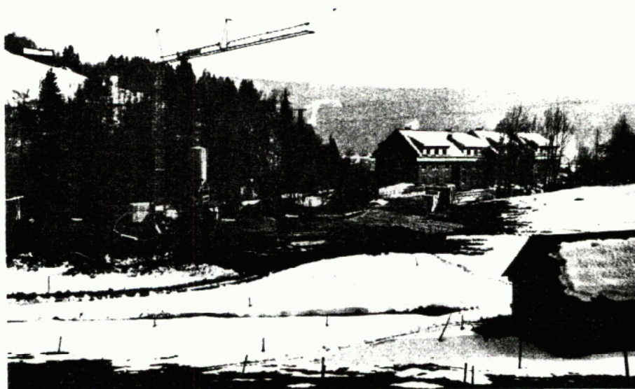
Auf den Sulzbachergründen im Oberdorf (1983 von der Stadtgemeinde aufgeschlossen) hat der Wohnungsbau begonnen. Die Siedlungsgenossenschaft Rottenmann wird 1984 19 Wohnungen, die Siedlungsgenossenschaft „ennstal“ 12 Wohnungen fertigstellen. Die „ennstal“ beginnt heuer außerdem wieder mit dem Bau von 35 Wohnungen.
