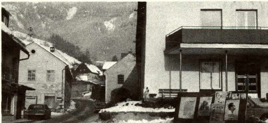
Die Einfahrt zur Höhenstraße im derzeitigen Zustand. Das zweite Haus links wird abgetragen, rechts kommt die Straße an die Kinomauer heran
