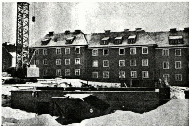
Trotz Schnee und Kälte geben die Arbeiten voran
