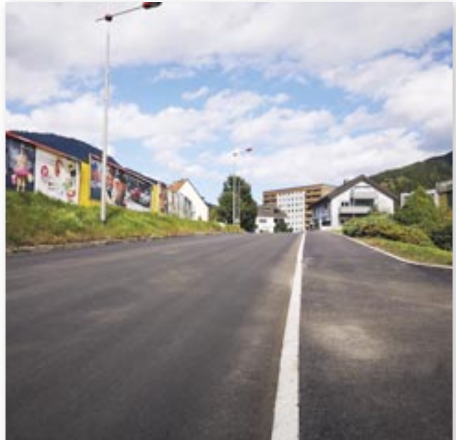
Ein wesentlicher Teil des jährlichen Straßenbau-Budgets, das rund eine Million Euro beträgt, ist in die Generalsanierung der Döllacher Straße geflossen. Vom Musikhaus Härtel bis zur Unterführung Höhe Schlosserei Walcher wurde der komplette Straßenaufbau neu gemacht. Das noch nicht sanierte Teilstück vom „Wutscher-Kreisverkehr“ bis zur Ausseer Straße erfolgt nach Fertigstellung aller Bauarbeiten am „Dumba-Park“.
